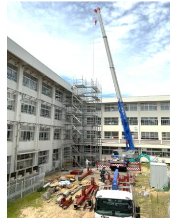
大きなクレーン車が活躍する エレベーター工事
